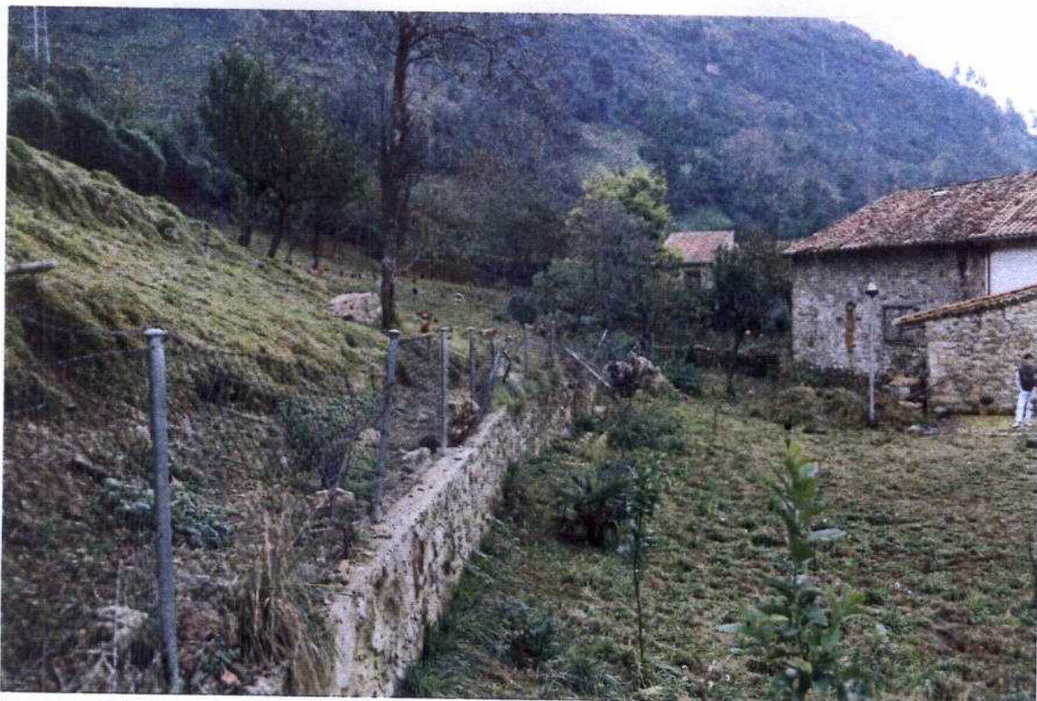
F. 6. Vista parcial de la zona de trayectoria/alcance (parte baja del talud) con piedras frenadas por algunos obstáculos.
