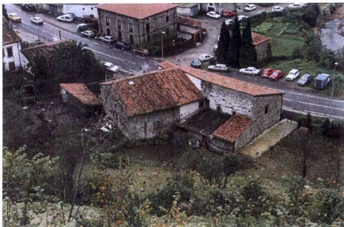
F. 5. Vista general de la parte trasera de las dos casas afectadas y del tramo de carretera N-634 (Zona de alcance).
